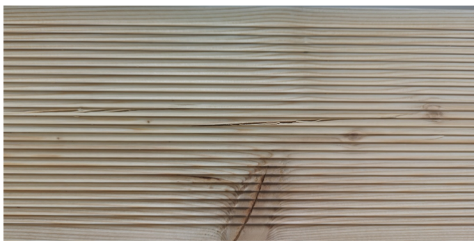
Křížové suky s malou prasklinou jsou povoleny
